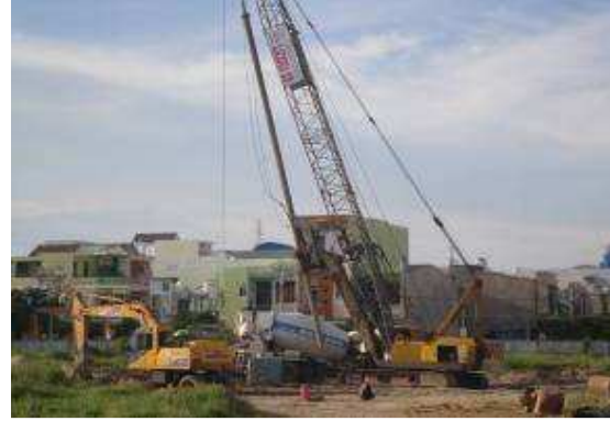
Thi công cọc khoan nhồi đại trà
