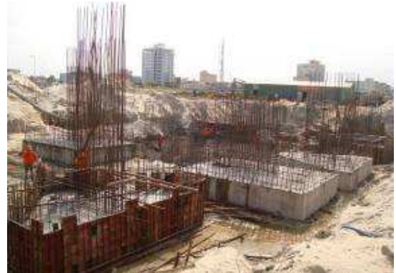
Thi công dầm móng
