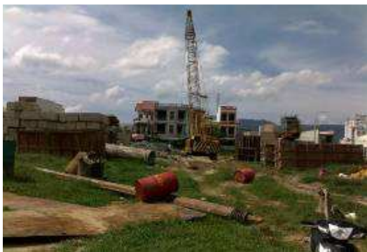
Thi công cọc khoan nhồi thử nghiệm
