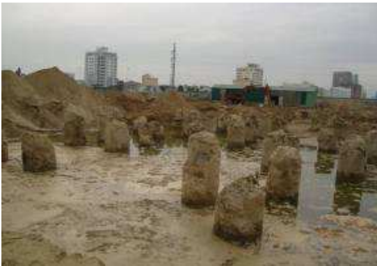
Thi công đập đầu cọc
